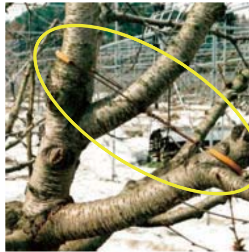
写真 44 ワイヤーによる補強状況
