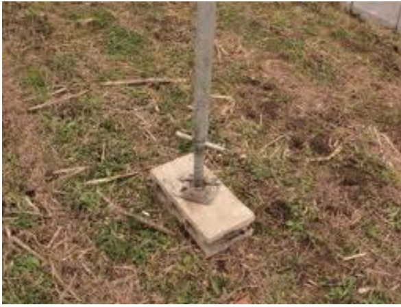
写真 15 中柱の沈み込みを抑えるためブロックを台石として設置
