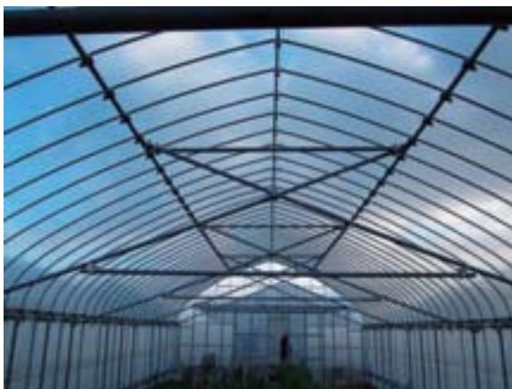
写真 13 パイプを用いてハウスを補強している状況
