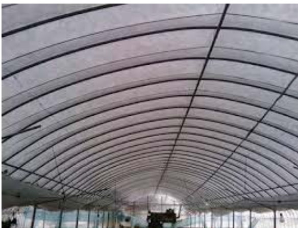
写真 32 屋根面に着雪し、融雪が必要となっているハウスの状況
