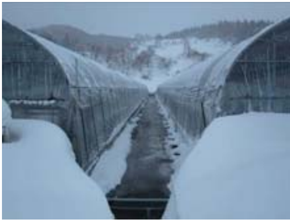
写真 18 屋根面から滑落した雪を地下水で消雪している状況
