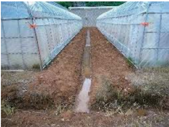
写真7 明きよの設置状況
