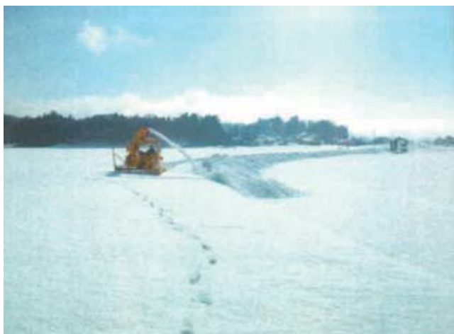
宮沢地区 作業中
