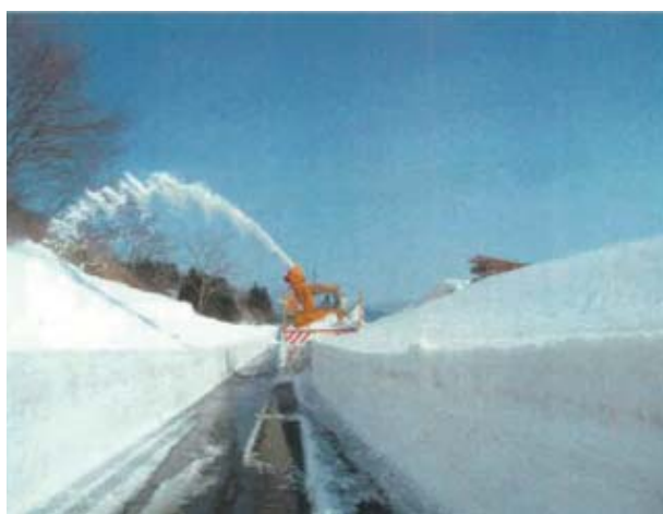
尾花沢地区 作業中
