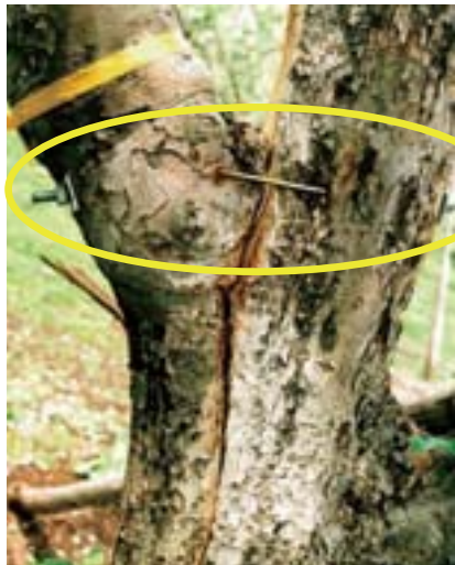
写真 43 ボルト、カスガイによる固定状況
