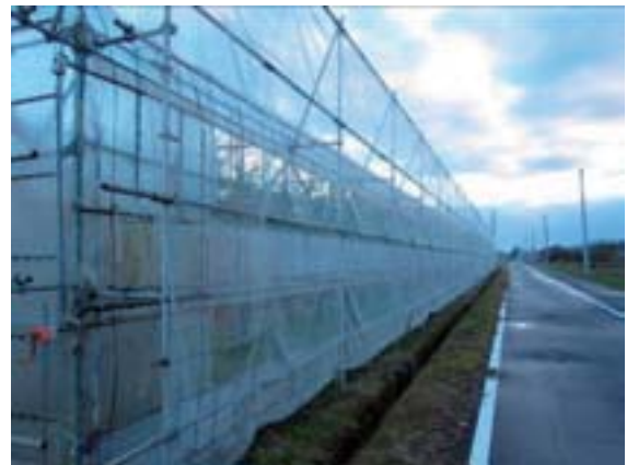
写真 23 おうとう加温ハウスの外側に防風ネットを設置した状況
