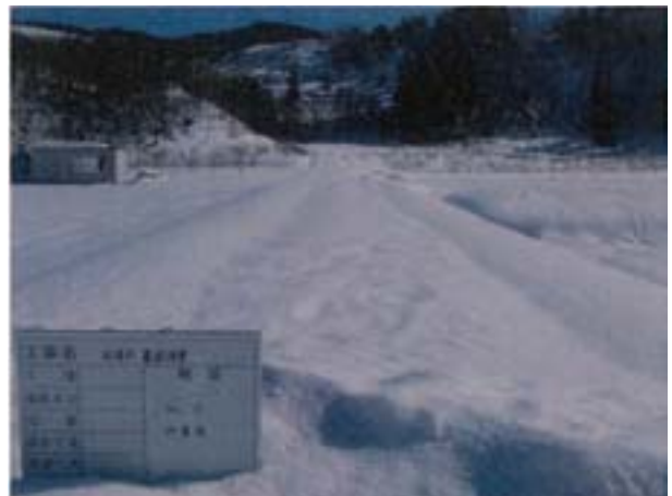
○金山地区 作業前
