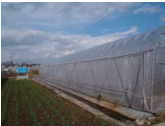
写真 16 ハウス外側に溝を掘り、ビニル等を敷設した状況
