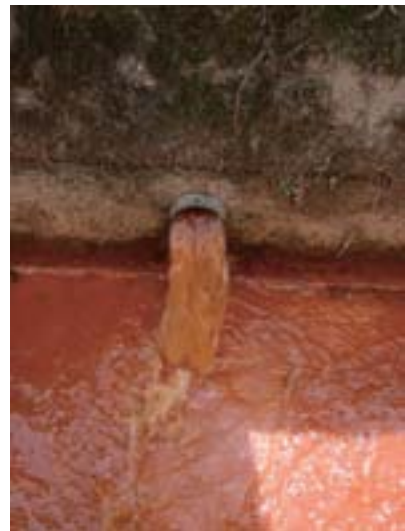
写真8 暗きよの排水口の状況を確認
