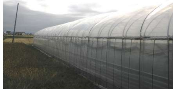
ハウスサイドは換気のため送風していない
