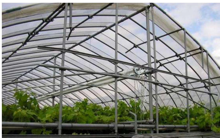
写真13 ハウスぶどうに追加設置された内張りカーテン用設備 (山形市)
