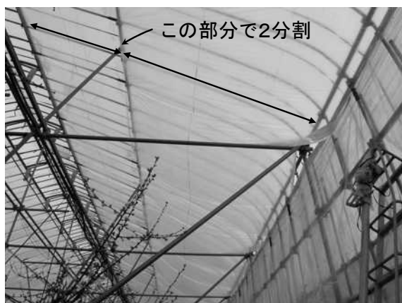
写真 15、16 おうとう加温ハウス栽培での屋根の2層改造例（写真提供：北村山農業技術普及課）
