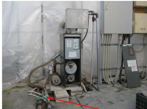
既存の温湯ボイラー配管と接続
