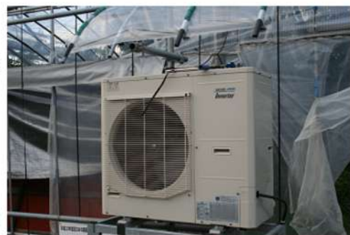
室外機の設置
