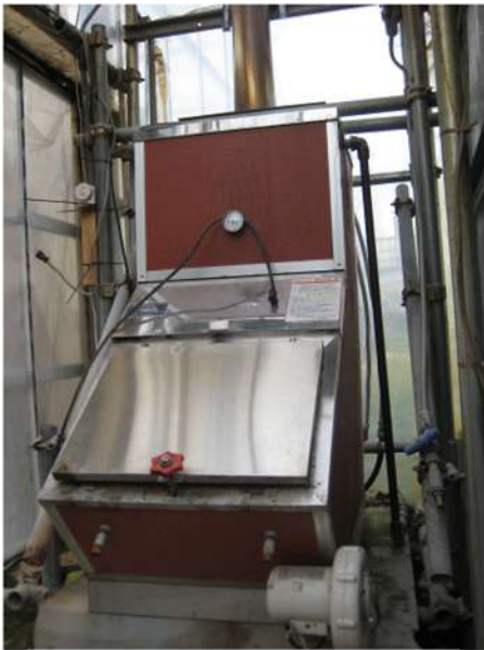
木質系燃温湯ボイラー （ウッドボイラー）
