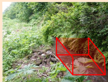
山腹水路の整備
