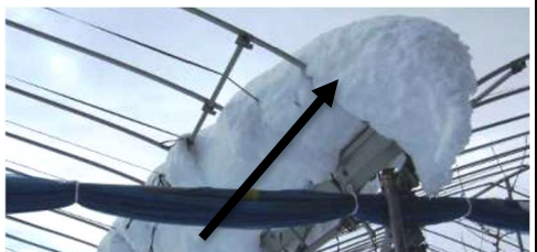
雨樋の雪は多くなる前、硬くなる前に下ろす
